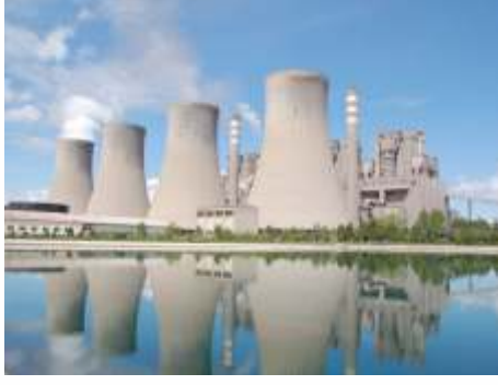
MARAŞ ELBİSTAN TERMİK SANTRALİ
